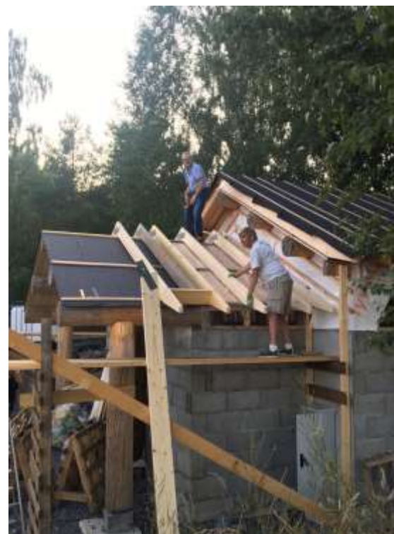
Figur 2 Jobbe videre med taksperrer
